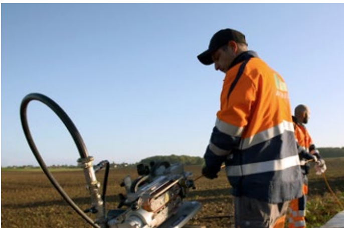
MiniXtend®光纖可用空氣輔助設備置入微型管道中
